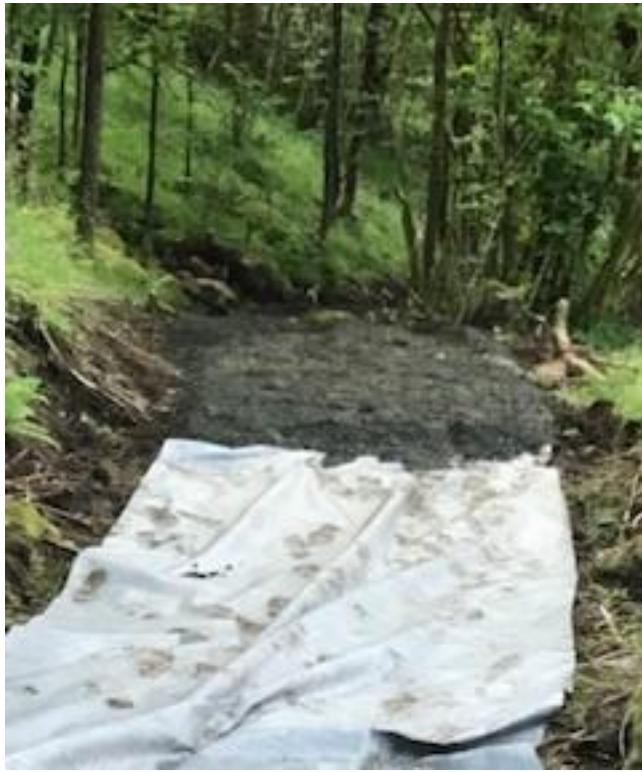
Figur 17. Fra arbeidet med utbedring av vegen. Legging av fiberduk og topplag i mai 2020. Foto Lars Steinberg.
