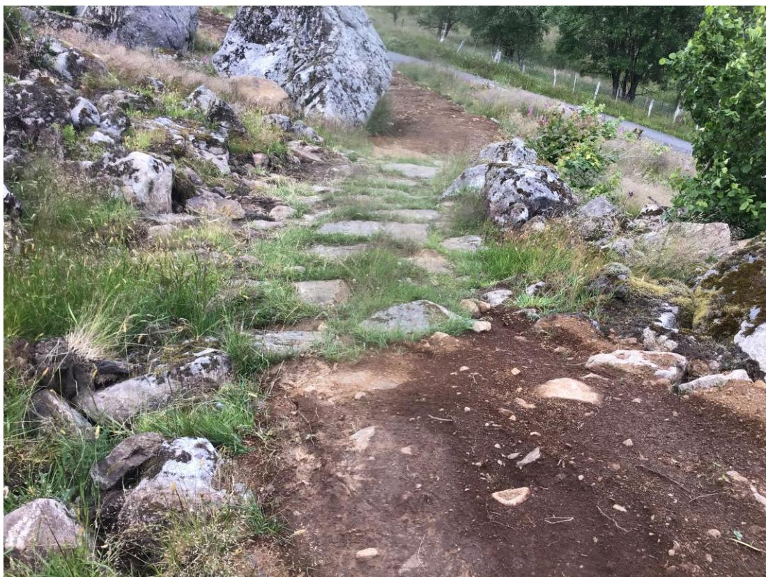
Figur 16. Steinsatt del er bevart uten endringer i vegutbedringen. Øvrige deler av den gamle driftestien er lagt under fiberduk og toppmassar. Foto RS 02.07.2020.
